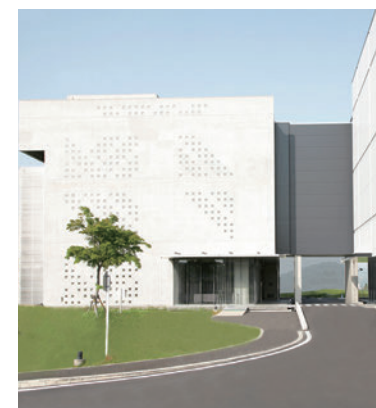
カゴヤ・ジャパン株式会社 データセンター
