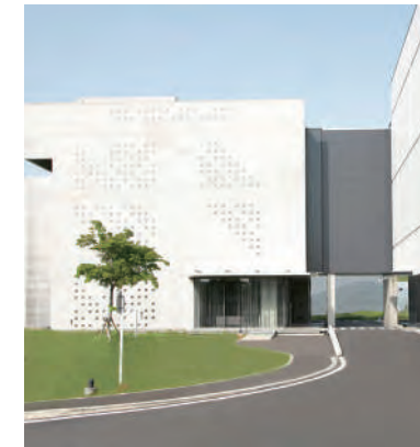
カゴヤ・ジャパン株式会社 データセンター
